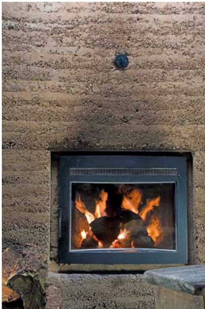
Integrierter Pellet-Primärofen in einer Wand mit grobem Lehmputz.
