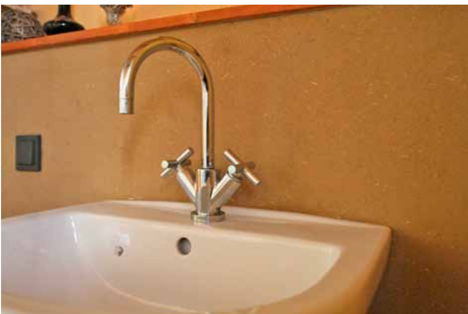
Lehmputz mit Leinölfirnis im Spritzbereich eines Handwaschbeckens.
