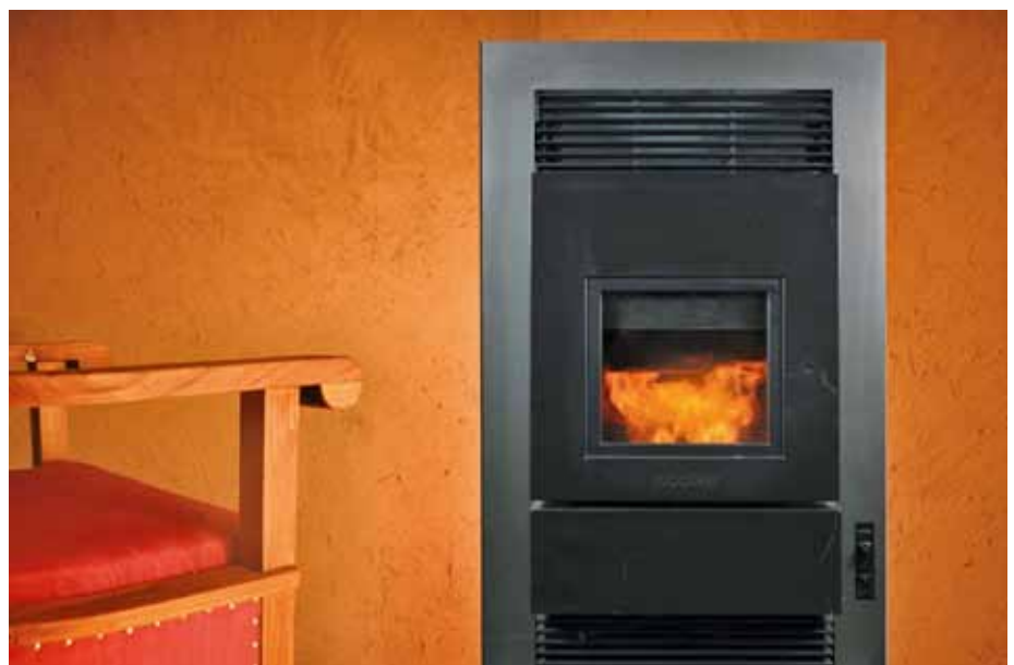
Wassergeführter Kaminofen in einer Stampflehmwand.
