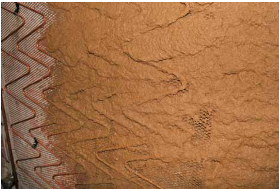
Erste Lehmputzlage auf einer Wandflächenheizung auf einen Untergrund aus Vollziegelmauerwerk im Rahmen einer Wohnraumerneuerung.
