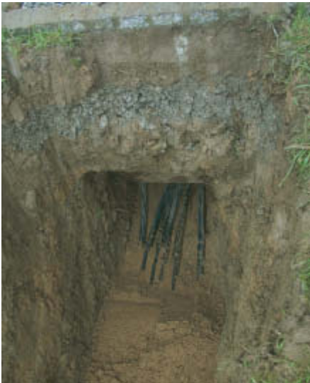
■ Einführung der Sondenanschlussleitungen in den Lichtschacht im Sandbett.
