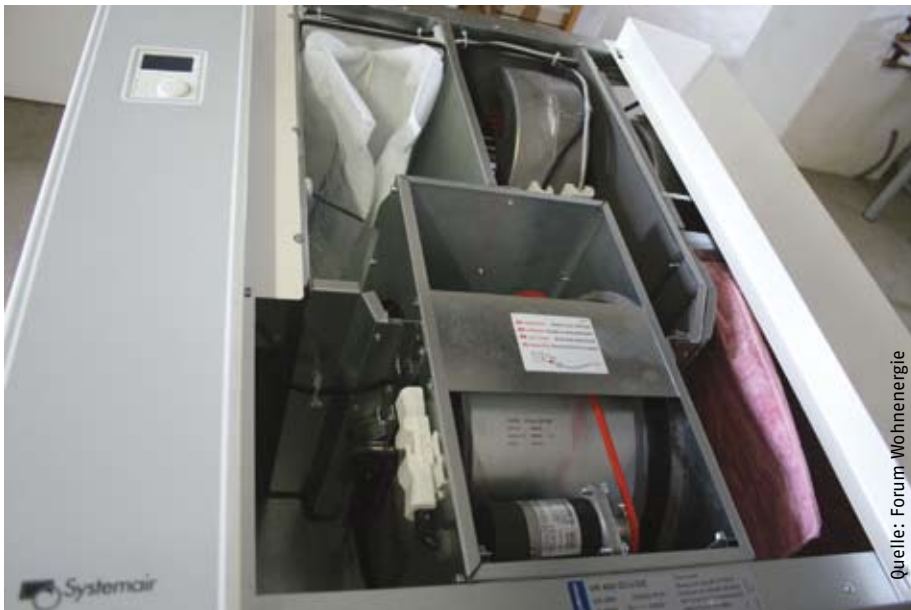
Wohnungslüftungsgerät mit Rotationswärmetauscher und zusätzlichem Filtereinsatz für medizinische Filter.
