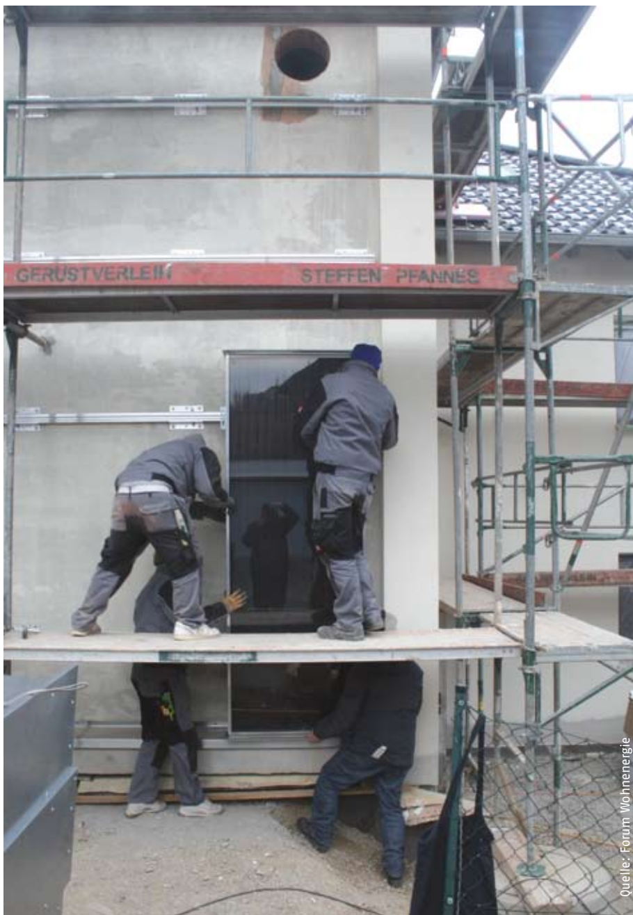
Luftkollektormontage an der Fassade eines Mehrfamilienhauses.
