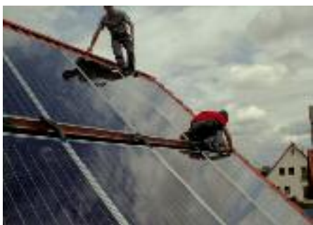
Montage eines Flachkollektorfelds
