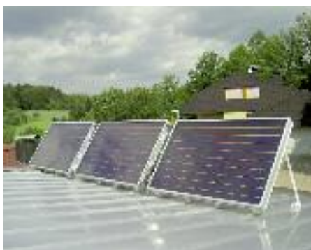
Aufständigung von Flachkollektoren auf einem Blechdach
