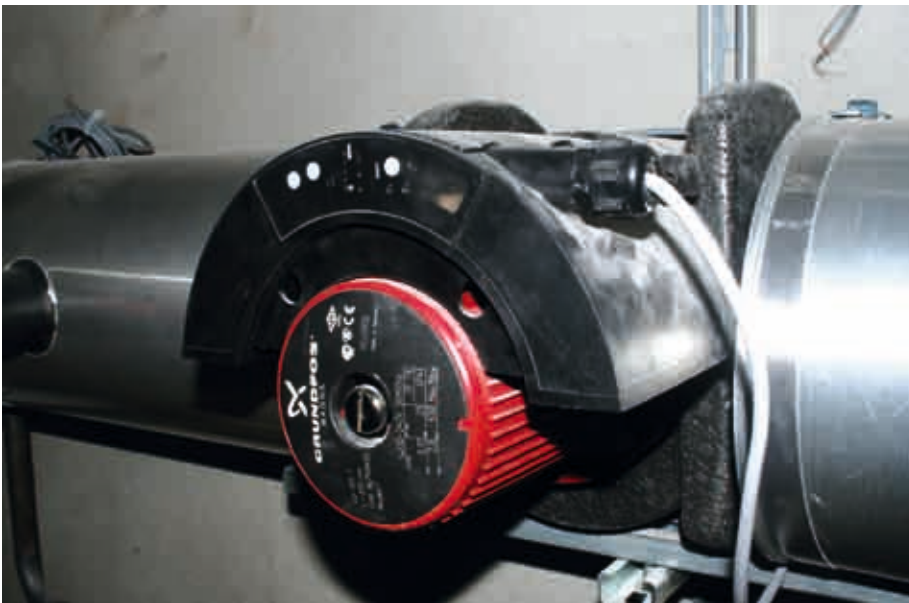
■ Drehzahlgeregelte Umwälzpumpe mit Wärmedämmschale.
