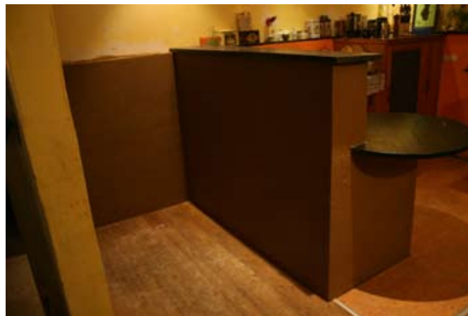
■ Wärmethke mit Wandflächenheizung und Lehmputz als Raumteiler während einer Umbauphase.
