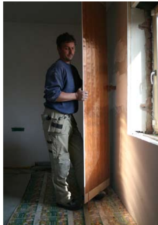
■ Montage von Trockenbau Wandflächenheizungen.
