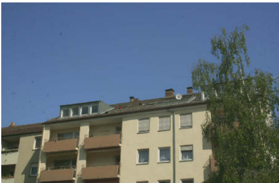
■ Solarthermische Anlagen sind leider noch sehr selten auf Mehrgeschosswohnbauten anzutreffen.
