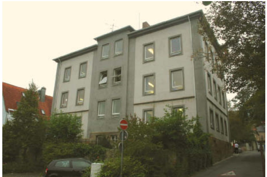
■ Fassade einer Grundschule mit maroden Fenstern auf Dauerlüftung während des Heizbetriebes.
