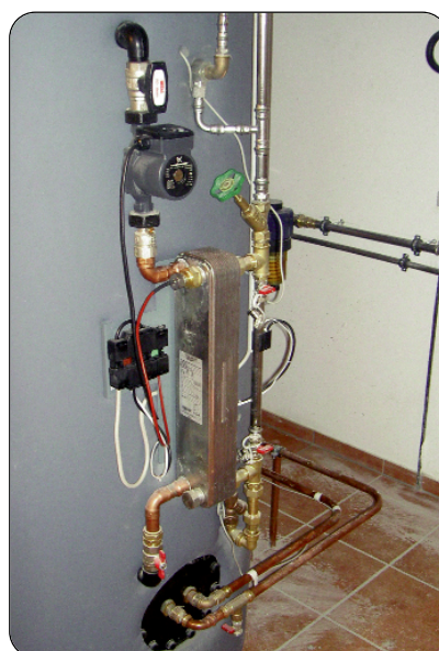
Bild 3: Heizungspufferspeicher mit externer Frischwasserstation unmittelbar am Speicher montiert
