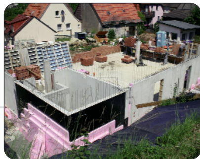
Bild 2: Bau des gebäudeintegrierten Wärmereservoirs
