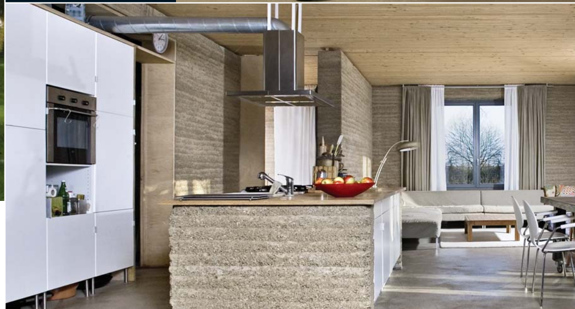
BROT UND SPIELE: Über der Wohnküche mit Essbereich befindet sich eine Holzbalkendecke auf den tragenden Stampflehmwänden.
