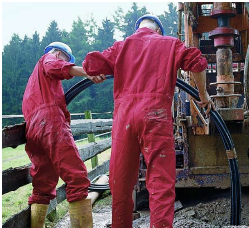
Vorbereitungen zur Sondenbohrung.
